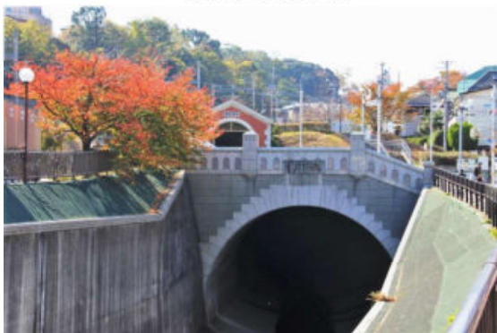
＜新湊川トンネル、上は湊川隧道入口＞
