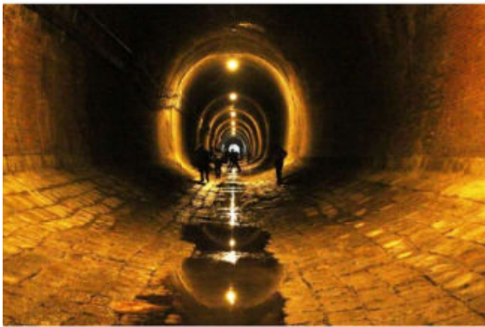
＜湊川隧道中央部＞
