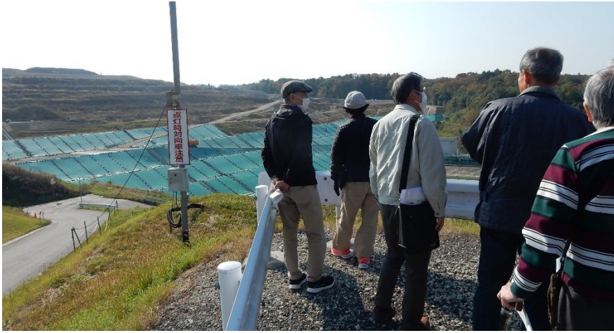
最終廃棄物埋め立て地全景
